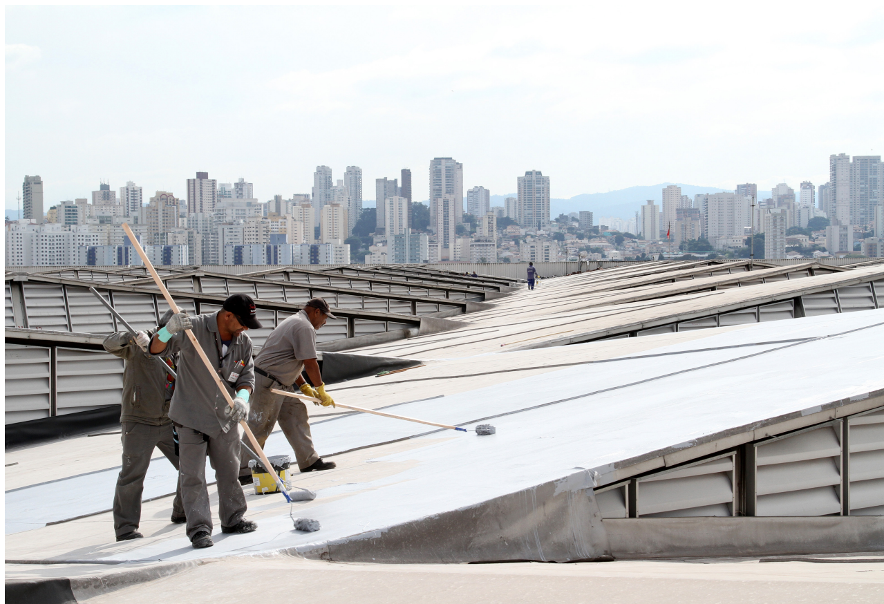
Impermeabilização do telhado do Pavilhão. Foto: Jose Cordeiro/ SPTuris.
