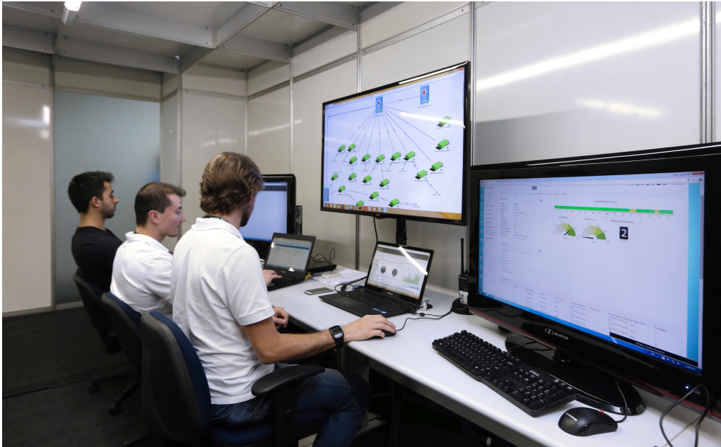
Painéis indicam a qualidade de conexão em todo o parque. Foto: Jose Cordeiro/SPTuris
