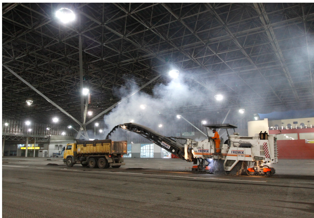
Obras para a troca do piso. Foto: José Cordeiro/ SPTuris.
