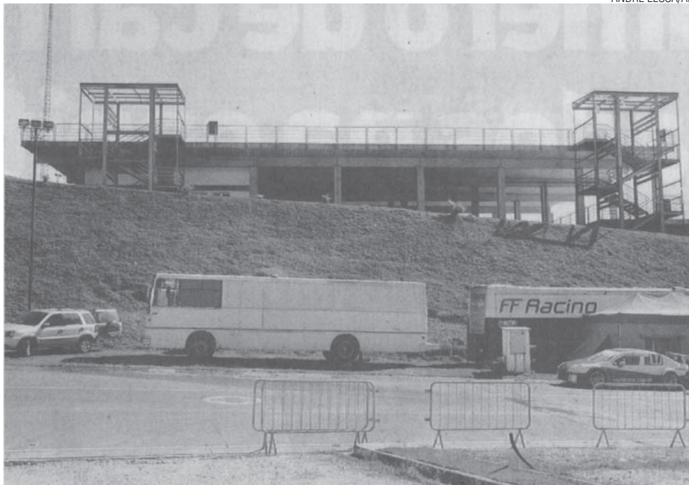
Área em que será construído o palco fixo no Autódromo de Interlagos: entre as duas escadas, sobre a via
