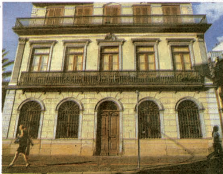
OBRAS – Casa de 1871 terá janelas, telhado e piso restaurados
