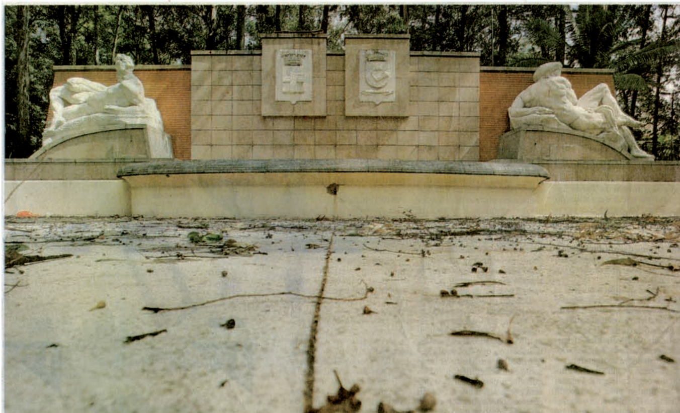
PRAÇA CIDADE DE MILÃO – As fontes do monumento erguido em parceria entre as duas cidades não funcionam, apesar de as instalações terem sido recuperadas em 2004
